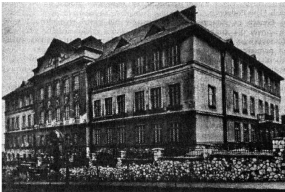
Rys. 36 Budynek Akademii Górniczej na Krzemionkach w Krakowie
